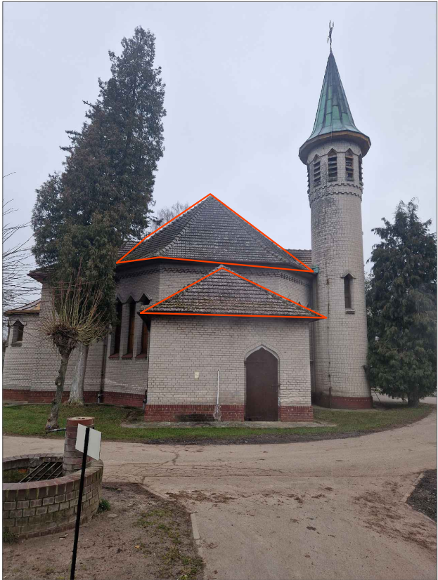
Dachówka nieszczelna popękana do wymiany
