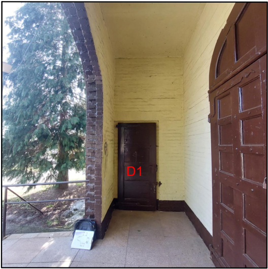
Drzwi D1 w przedsionku do wymiany. Ściany do renowacji
